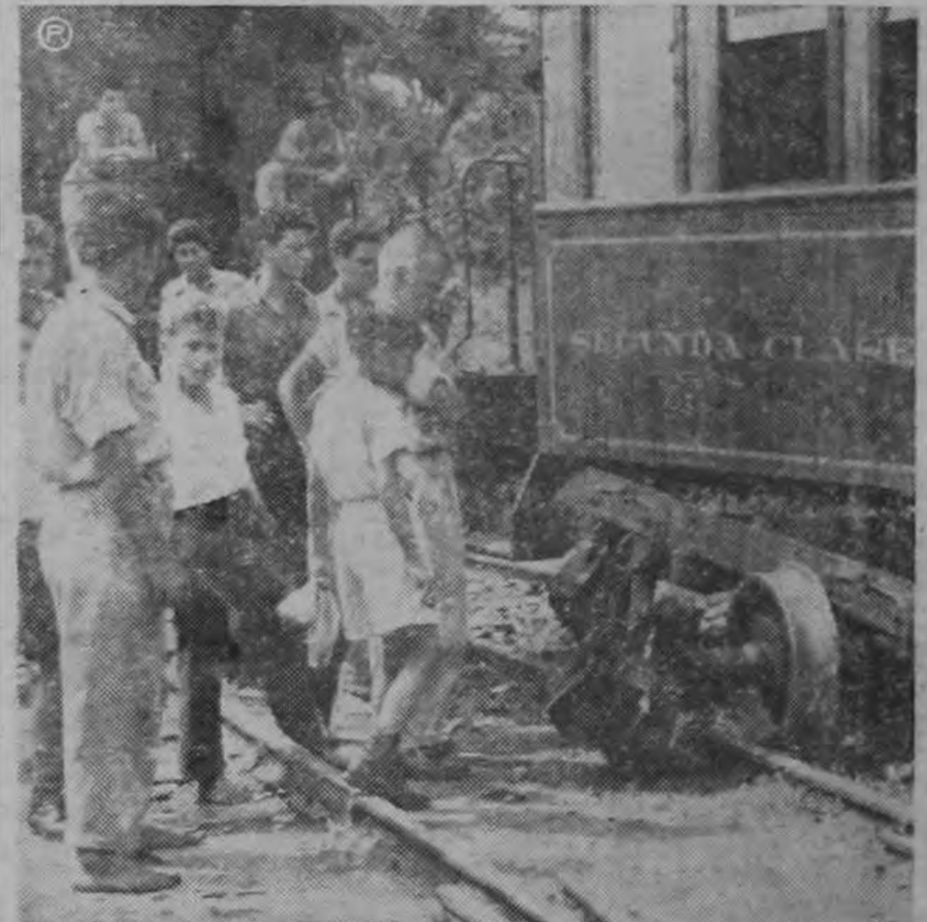
Casi al llegar a la estación del Pacífico, en el kilómetro 1 de la línea ocurrió ayer un descarrilamiento, que se presume causado por haberse desprendido uno de los eslabones de la cadena del sistema de ruedas.—Foto AREVALO)
